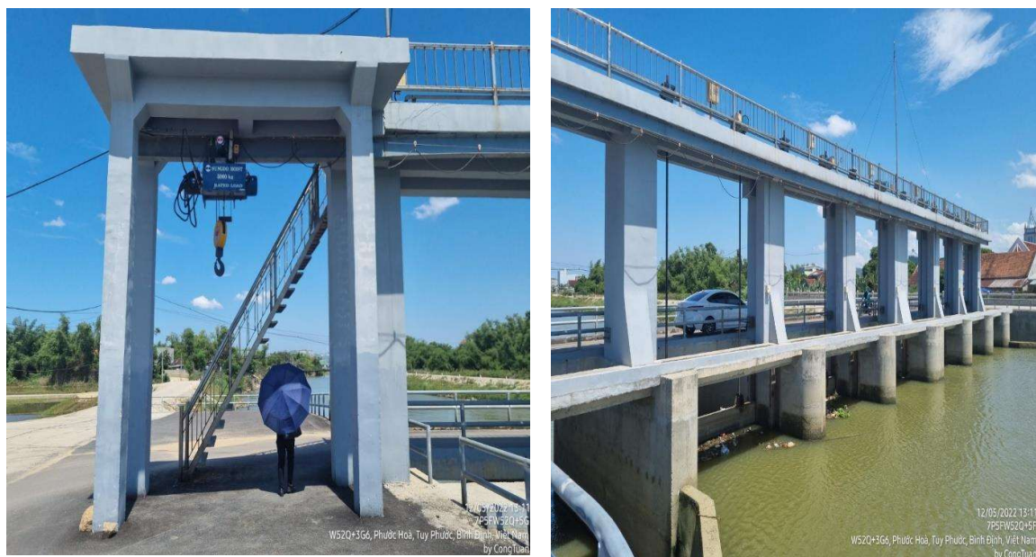
Hình 11: Một hình ảnh khảo sát tại công trình đập ngăn mặn Nha Phu
